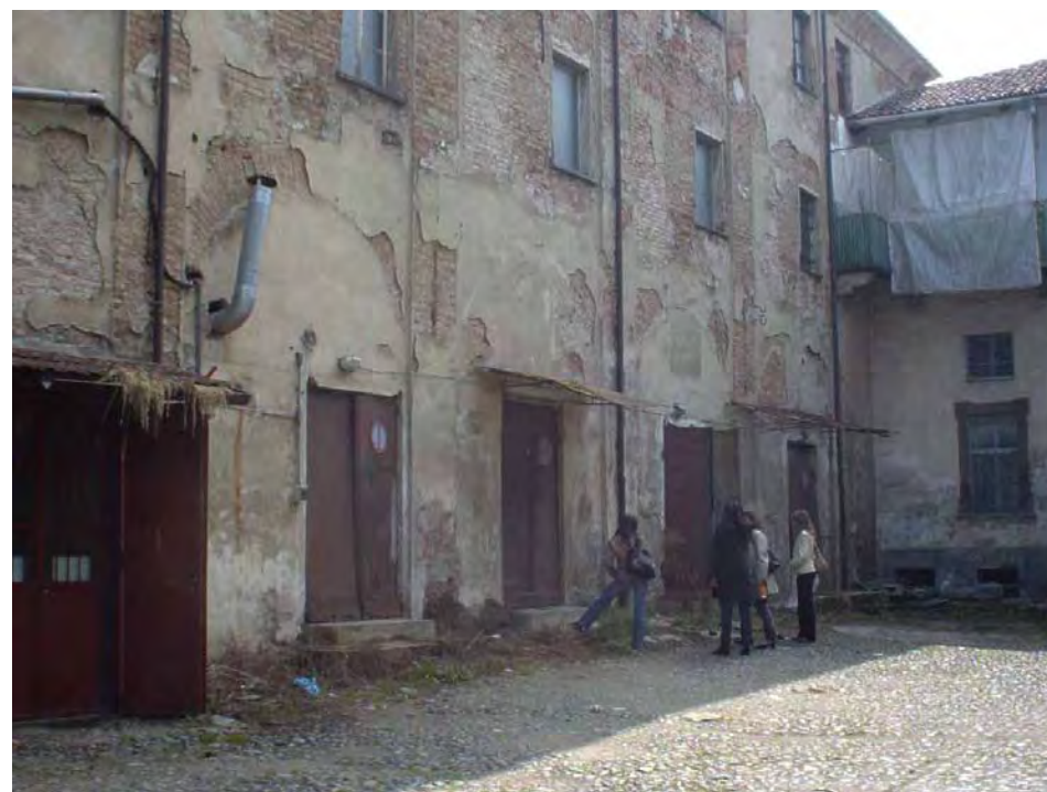
Interno cortile verso via Mensa
