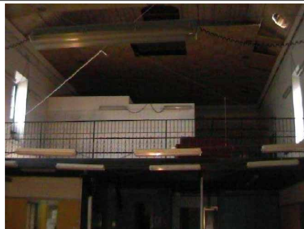
Piano terreno – Vista verso la ex galleria
