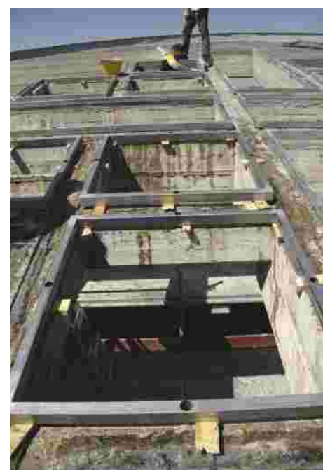
Lavori di messa in sicurezza del lucernario al cimitero di Venaria
