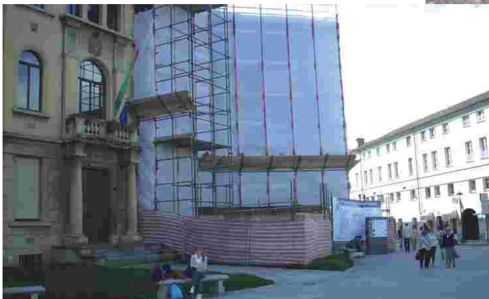
Al via i lavori di restauro della scuola De Amicis. In alto, il cantiere della nuova biblioteca
