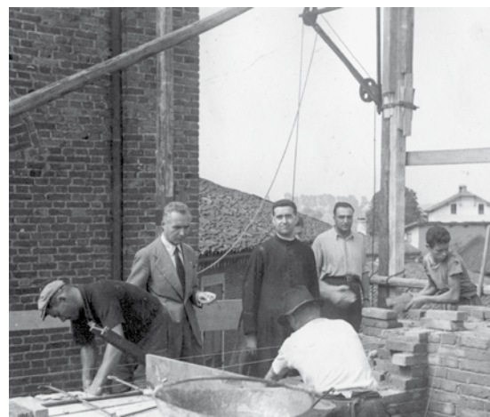
Sopra, Don Mosso mentre segue dei lavori di ristrutturazione.
